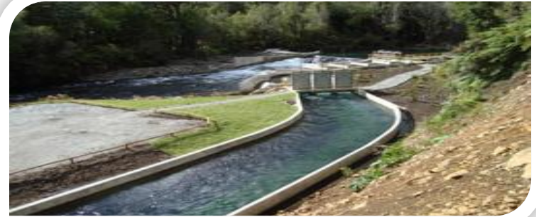
Autoconsumo eléctrico Mini hidros de pasada
