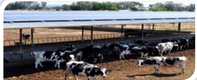
Autoconsumo eléctrico Paneles Fotovoltaicos
